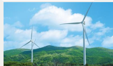
リエネ松前風力発電所
