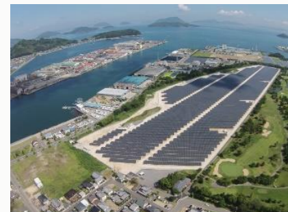
詫間太陽光発電所 (香川県)
