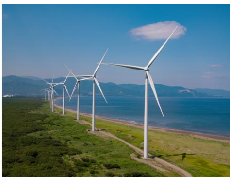
（リエネ銭函風力発電所）
