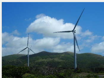
リエネ松前風力発電所 （北海道）
