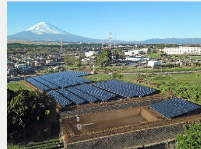
自社施設へ直接電力を提供する リネ静岡神山太陽光発電所
