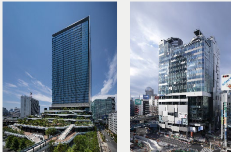
再生可能エネルギーへの切替えが完了した主な物件 (左：東京ポートシティ竹芝、右：渋谷フクラス)
