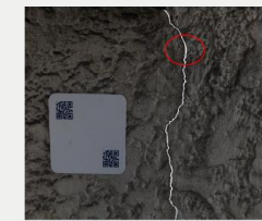
外壁画像とクラックを合成 最大幅部分を特定
