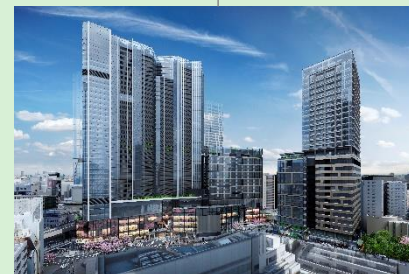
Shibuya Sakura Stage (渋谷駅桜丘口地区再開発計画) 渋谷区 オフィス/商業/住宅 延床面積：255千㎡ 2023年11月竣工予定
