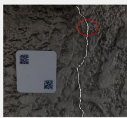
外壁画像とクラックを合成 最大幅部分を特定
