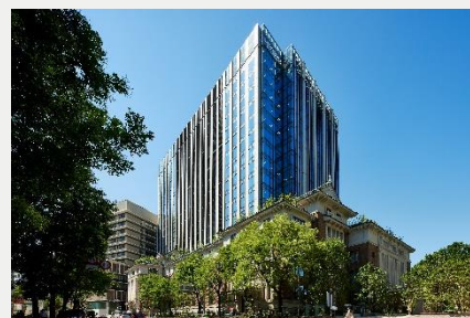
最新鋭オフィスの新築部分
